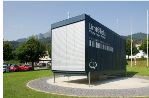
FIG. 24 Aussenansicht Rafflamelle silber, perforiert, geschlossen
