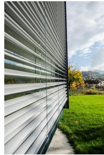
FIG. 5 Aussenansicht Lichtmesscontainer mit Rafflamellensonnenschutz
