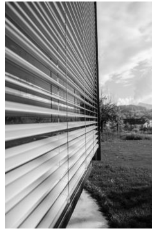
A FIG. 54 Lichtmesscontainer Aussenansicht mit Rafflamellensonnenschutz
