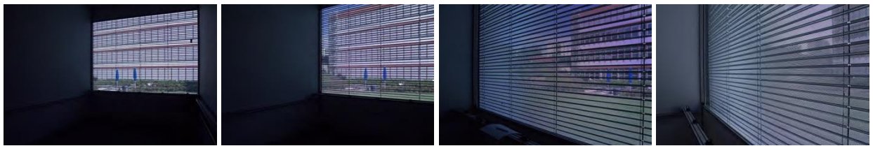
FIG. 37: Sonnenschutz mit perforierter Rafflamelle: Rafflamellenstoren; Betrachtung bei unterschiedlichen Entfernungen und Winkeln
