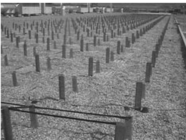
Bild 65. Aufbau in Schritten: die Platten sind fertig verlegt und mit zusätzlichem Kies gleichmässig beschwert
