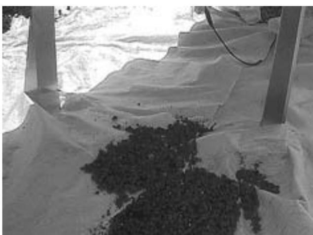
Bild 71. Aufbau in Schritten: Verteilen und Ausgleichen des Substrates unter den Modulen, welches wegen der Stützen und Module nicht maschinell erfolgen kann, sondern durch Handarbeit erledigt werden muss.
