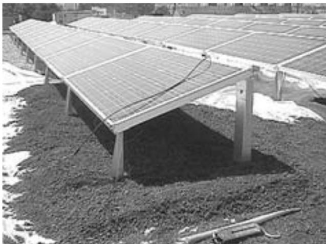
Bild 72. Aufbau in Schritten: Fertig verlegtes und montiertes Solarmodul mit Unterkonstruktion und fertig eingebrachtem Schutzvlies und Substrat.
