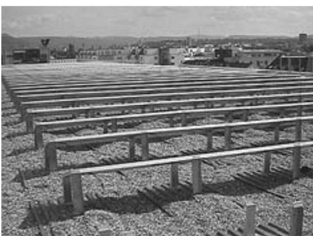
Bild 66. Aufbau in Schritten: die Module werden mit den Stützen dauerhaft verbunden
