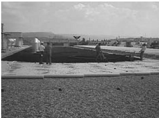
Bild 69. Aufbau in Schritten: Verteilen und Ausgleichen des Substrates, welches je nach Dach zwischen ca. 3 und 12 cm dick ist.
