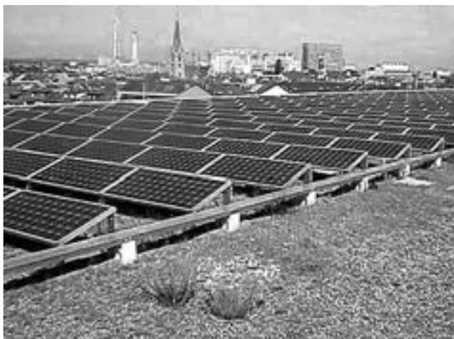
Bild 62. Teilaufnahme einer grossen Solarstromanlage auf einem Gründach. Als Schwerlastfundation wurden unter dem Kies und unter dem Substrat für den Pflanzenwuchs gewellte, rezyklierte Polyäthylenplatten eingesetzt
