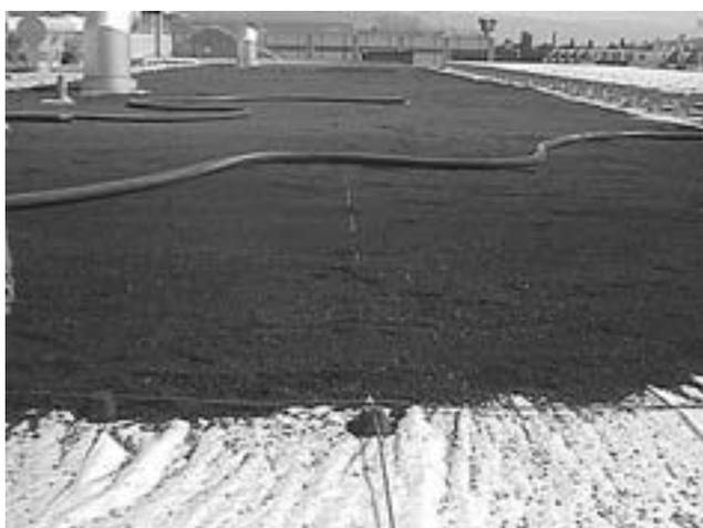
Bild 70. Aufbau in Schritten: Teilweise fertig verlegtes Substrat und Schutzvlies.
