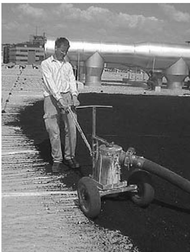
Bild 68. Aufbau in Schritten: Einbringen des Substrates auf die fertig verlegte Schutzvliesbahn. Das Substrat dient als Boden Verankerung und Nahrung für den Pflanzenwuchs.
