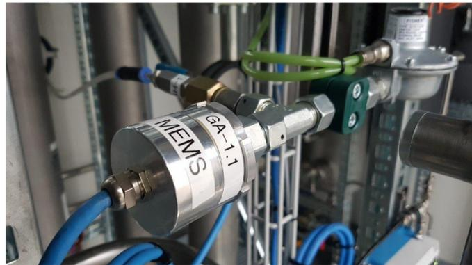
Abbildung 10: Der gasQS® von MEMS AG ist schnell montiert
