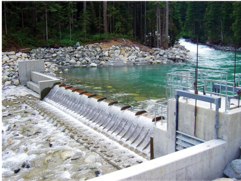
Abbildung 11: Grosse Wasserrfassung mit einem Coanda-Rechen in Kanada
