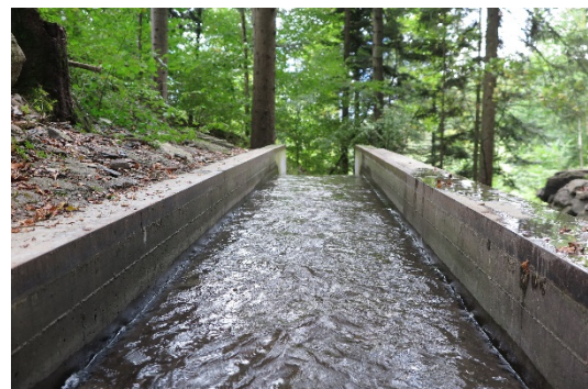
Abbildung 21: Zulauf Coanda-Rechen
