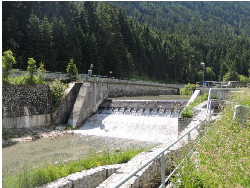
Abbildung 9: Fassung am Vallerbach bei Vals, Südtirol
