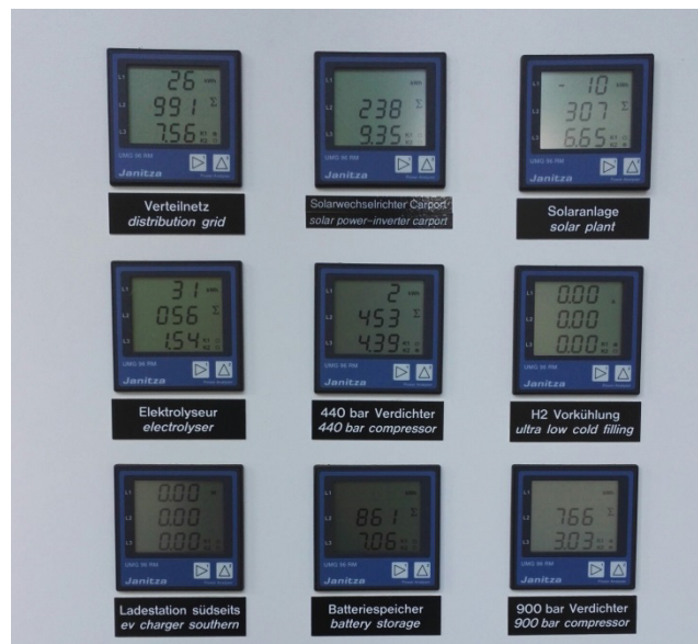
Abb. 18 Anzeigeeinheiten der Stromzähler für die Hauptkomponenten im move
