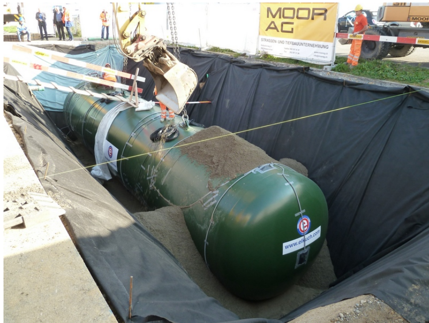
Abb. 9 Erdverlegung des Puffertanks an der Tankstelle in Hunzenschwil (Quelle: CMA)
