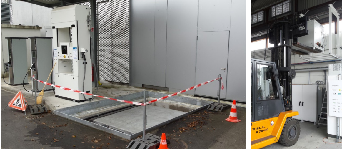
Abb. 4 Links: offener Betonschacht mit isoliertem Aluminiumblock (Wärmetauscher), rechts: Installation des Kältekompressors
