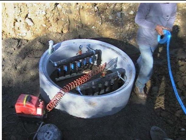
Subverteiler: Die Anlage wird schrittweise abgepresst und die Leitungen mit Warnband gekennzeichnet
