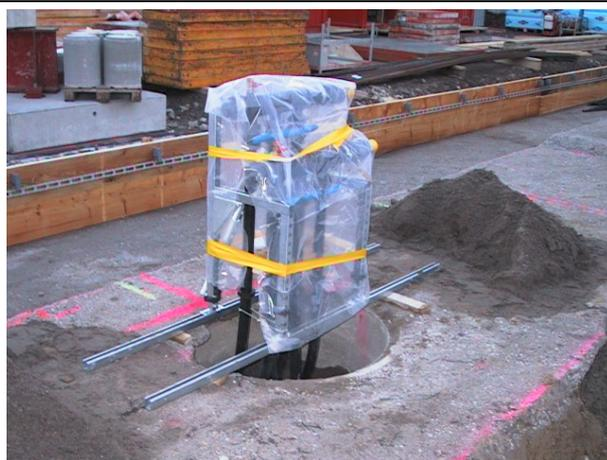
Hauptverteiler mit wasserdichten Durchführungselementen im Heizungsraum
