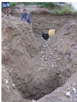
Ein Bagger mit einer 60 cm breiten Schaufel hebt ein Loch bis in eine Tiefe von 3.5 Meter aus.
