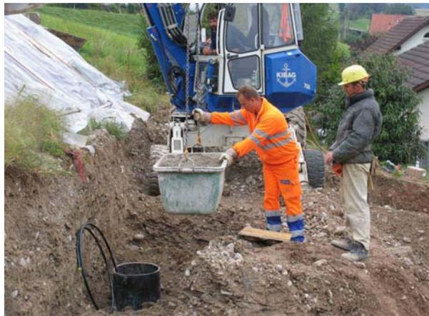
Abbildung 9: Sandhinterfüllung innerhalb des Erdwärmekorbes
