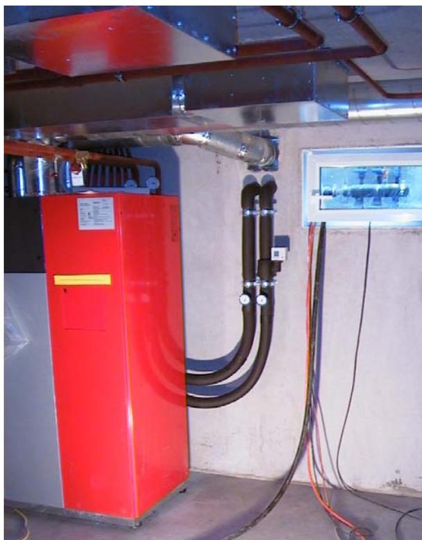
Abbildung 11: Verteiler und angeschlossene Wärmepumpen
