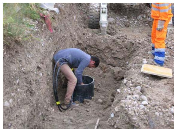
Abbildung 6: Einbau des Erdwärmekorbes im Schutzrohr.
