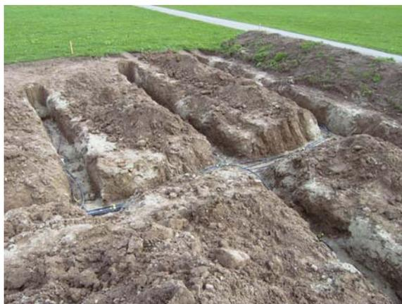
Abbildung 10: Beispiele für die horizontale Verrohrung der Erdwärmekörbe. Die Zuleitungen werden eingesandet.
