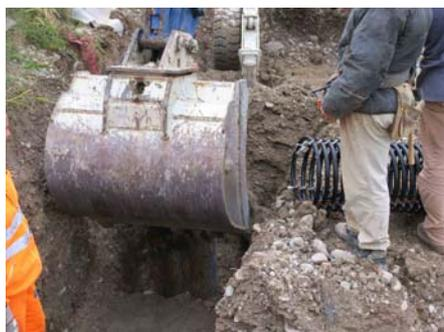
Abbildung 5: Einbau des Schutzrohres (links) und Hinterfüllung mit dem Aushubmaterial (rechts)
