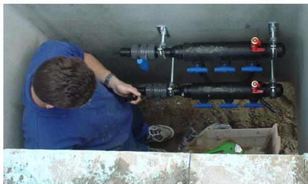
Setzen des Verteiles für 9 Erdwärmekörbe in Lichtschacht an der Hauswand oder innen im Heizungsraum (links Anlage mit 18 EWK inkl. Wärmepumpe).
