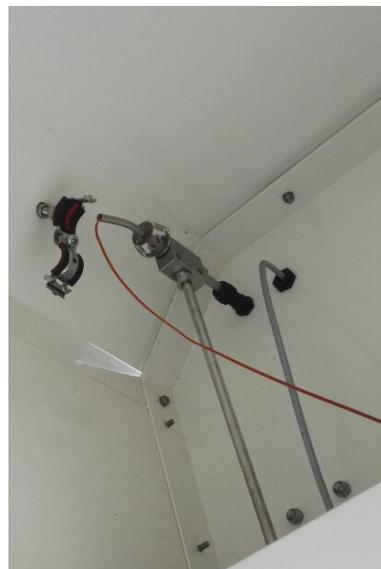
Abb. 1 Ersetzter Temperatursensor in H<sub>2</sub>-Zapfsäule unmittelbar vor Betankungsschlauch (links: Position Sensor)
