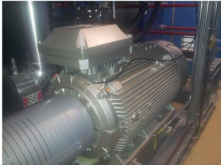
Abbildung 3 Ein mit Frequenzrichter betriebener Motor aus dem Pilotversuch, welcher aufgrund von Lagerstrom- Problemen später mit Aegis Ringen nachgerüstet wurde
