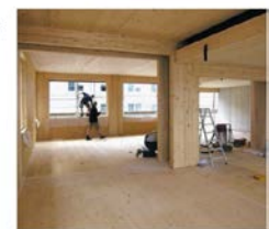
Abbildung 119: Gebäudetyp 10 Leichtbau – Stützträgersystem Holz, Aussenwände in Holzrahmenbau.
