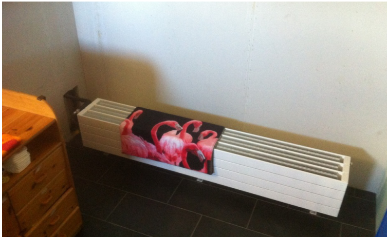
Abb. 32: Konvektor im Badezimmer. An dieser Stelle ist eine Sauna geplant, wenn der Wickeltisch einmal nicht mehr gebraucht wird. Der Konvektor kommt aber schon jetzt zum heizen des Badezimmers oder Vorwärmen der Frotteewäsche (minutenweise) zum Einsatz. Bei Messungen hat der Konvektor bei maximaler Speichertemperatur (95°C) eine Leistung von bis zu 15 kW abgegeben. Das ist doppelt so viel, wie das Haus im Auslegungsfall benötigt. Ziel ist es, die Sauna alleine mit dem Konvektor beheizen zu können.
