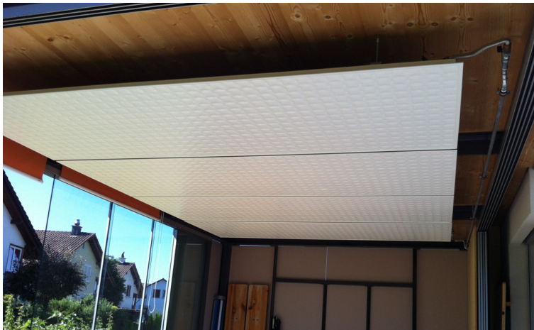
Abb. 33: Wärmestrahler in der Pergola. Im Sommer liefert die Solaranlage deutlich mehr Energie als benötigt wird. Aber auch im Sommerhalbjahr gibt es an Abenden oder verregneten Wochenenden Momente, wo zusätzliche Wärme willkommen ist. Bei einer Messung mit einer Aussentemperatur von 17 °C und 83 °C Vorlauftemperatur erzeugte der Strahler auf voller Stufe innert 10 Minuten eine Raumtemperatur von 27 °C, nach weiteren 10 Minuten von 33 °C. Die abgegebene Leistung betrug anfänglich 17 kW. Nach dem Ausschalten klang die Temperatur innert 2 Stunden wieder auf 22 °C ab.
