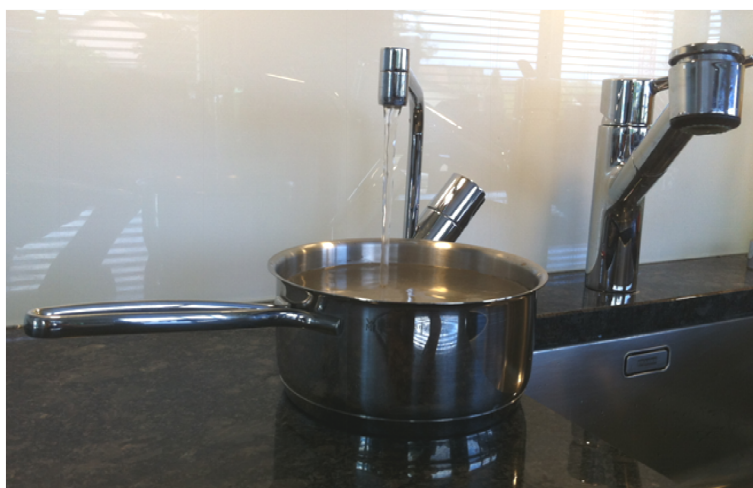
Abb. 31: Am Heisswasserhahn mit Sicherheitsdrehknopf fließt bis zu 95^{\circ}\text{C} heisses Wasser direkt aus dem Speicher (nicht via den Verbrühungsschutz). Damit lassen sich Tees oder Suppen direkt ab dem Hahn zubereiten, Gläser für Konfitüren sterilisieren oder einfach Wasser fürs Kochen zapfen. Ca. 6 Monate im Jahr ist das Wasser über 90^{\circ}\text{C} , weitere 3 Monate über 70^{\circ}\text{C} .
