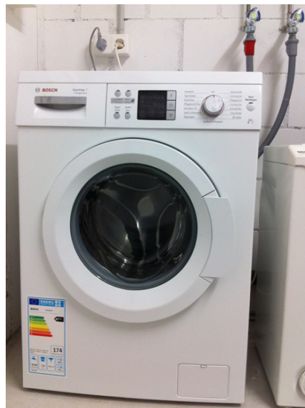
Abb. 30: Geschirrspüler (links) und Waschmaschine sind beide am Warmwasser angeschlossen. In einem Haushalt mit vier Kindern sind die Geräte praktisch täglich im Einsatz. Auch dann sollte darauf geachtet werden, dass die Geräte möglichst in der obersten Klasse des Energieetiketts sind.
