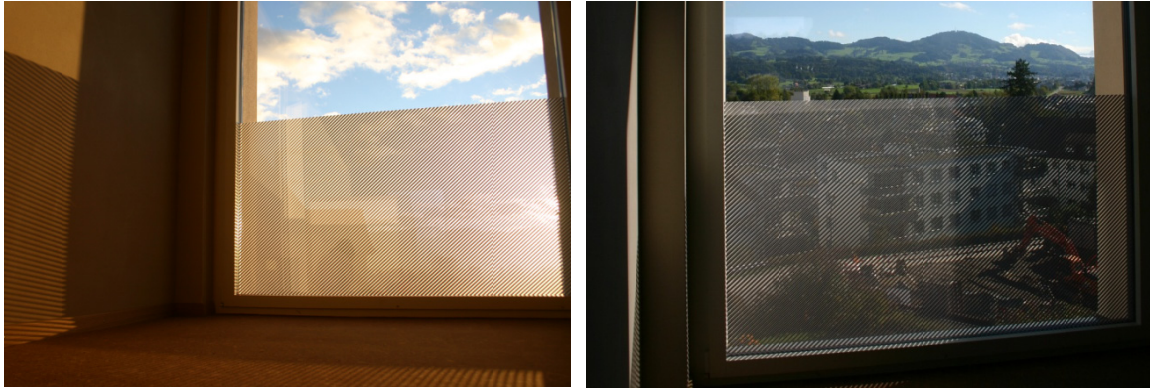
Abb.25: Fenster auf der Ostseite mit SunPattern (unterer Bereich). Das linke Bild zeigt eine Blickrichtung, bei der die äusseren, sandgestrahlten Streifen das Licht diffus streuen. Das rechte Bild zeigt an demselben Fenster eine Blickrichtung, bei der die Sandstrahlung durch die Spiegelstreifen verdeckt ist und die klaren Bereiche eine klare Durchsicht erlauben.
