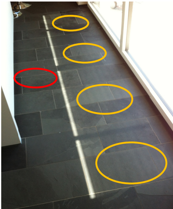
Abb.23: Rechts: Optische Wirkung von SunPattern im Gebäudeinnern: Die Sonne steht genau im Zenit. Die Ellipsen markieren die Bereiche von vier Vordachgläsern. Man erkennt, dass die Abschattung fast vollständig ist (vergleiche rote Ellipse) und bei allen Gläsern etwa die gleiche Intensität besteht. Der helle Lichtstreifen kommt von einem kleinen Berechnungsfehler bei der absoluten Position der Gläser.
