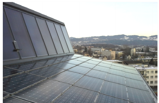
Abb.14: Die Konterlattung vom flachen zum steilen Dachabschnitt sind so angelegt, dass eine zusammenhängende Hinterlüftung entsteht. Im flachen Teil erwärmt sich die Luft hinter den PV-Modulen. Die vorgewärmte Luft führt beim thermischen Kollektor zu höheren Erträgen. Durch den Kamineffekt wird stetig neue Luft angesaugt, welche die PV-Module kühlt und so dort ebenfalls eine Ertragssteigerung bewirkt. Auf der Vorderseite der Module entsteht zudem eine warme Luftschicht. Bei geringer Windgeschwindigkeit bewirkt diese eine weitere Erhöhung des solarthermischen Ertrages.
