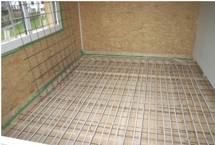
Abb.13: Vorbereitung zum Betonieren der Holz-Beton-Verbunddecke: Der Unterbau besteht aus einem 12 cm dicken Brettstapel, der lediglich durch runde Querhölzer zusammengehalten wird. Beim Betonieren quillt das Holz auf, wodurch Ritzen verschlossen werden. Um Verformungen der Decke beim Betonieren zu vermeiden sollte der Brettstapel gespleisst werden bis der Beton ausgehärtet ist. Die Betonlage wird 14 cm dick.
