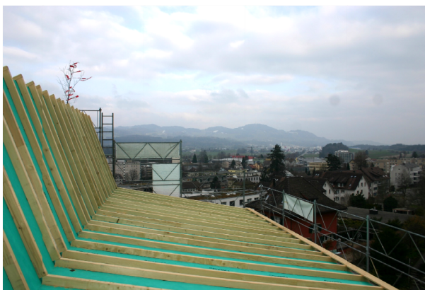
Abb.14: Die Konterlattung vom flachen zum steilen Dachabschnitt sind so angelegt, dass eine zusammenhängende Hinterlüftung entsteht. Im flachen Teil erwärmt sich die Luft hinter den PV-Modulen. Die vorgewärmte Luft führt beim thermischen Kollektor zu höheren Erträgen. Durch den Kamineffekt wird stetig neue Luft angesaugt, welche die PV-Module kühlt und so dort ebenfalls eine Ertragssteigerung bewirkt. Auf der Vorderseite der Module entsteht zudem eine warme Luftschicht. Bei geringer Windgeschwindigkeit bewirkt diese eine weitere Erhöhung des solarthermischen Ertrages.
