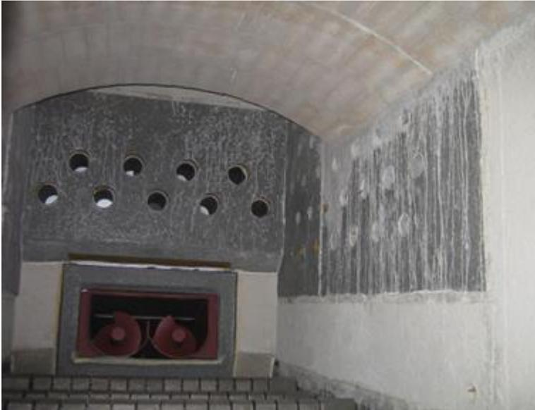
**Abbildung 2 Brennkammer mit Doppelstoker, Öffnungen für Abgasrückführung (hinten) und Turbinenabluft (seitlich)**
