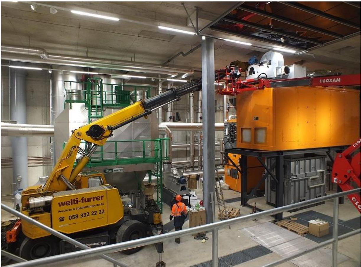
Abbildung 6 Montage des Abgarrückführventilators in der Heizzentrale Düdingen
