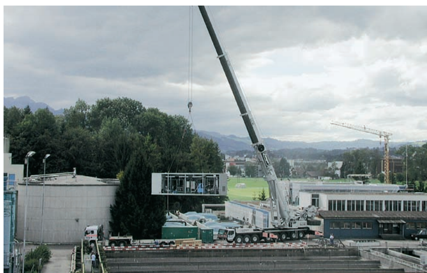
Abb. 7 Montage des Containers mit Pneumkan.
