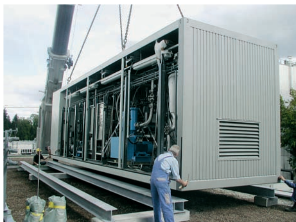
Abb. 8 Endmontage des Containers mit der Aufbereitungsanlage auf dem Dach des Maschinenhauses.
