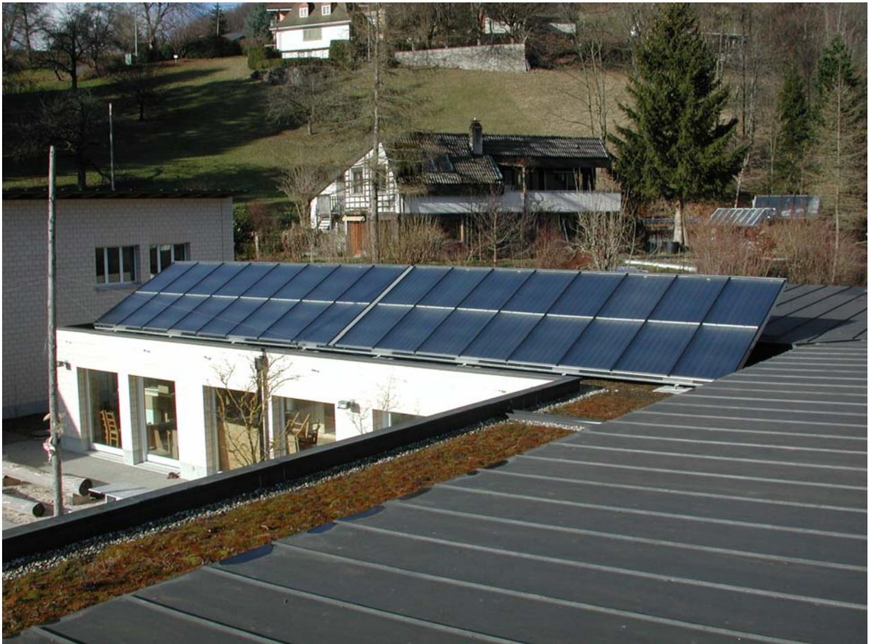
Abb. 3.1.1 Das Kollektorfeld auf dem Flach Dach eines Heimtraktes
