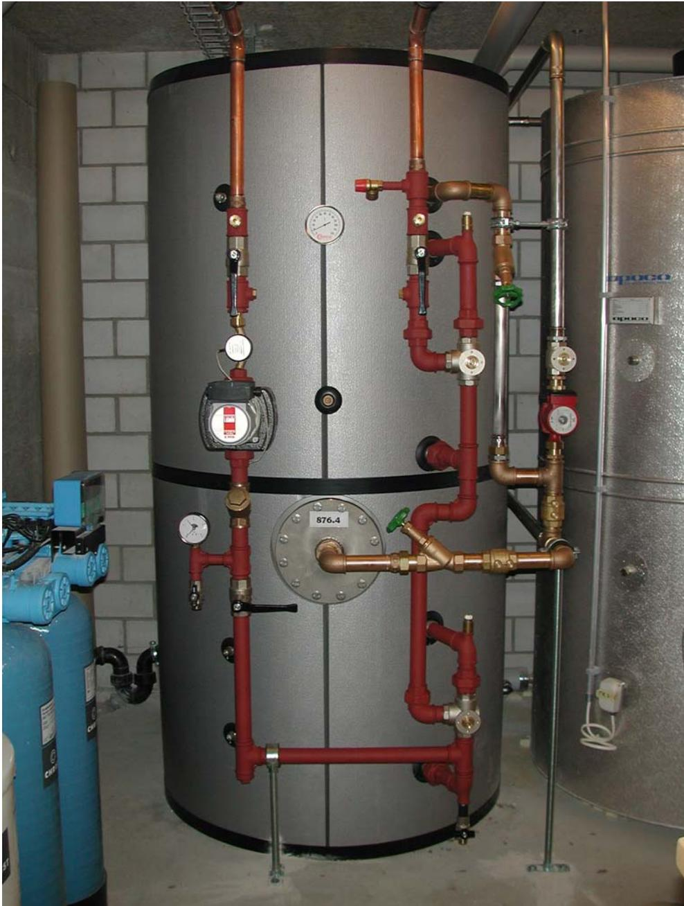
Abb. 3.1.2 *Der neue Wassererwärmer mit 1'250 Liter Inhalt und 2 Wärmetauscher mit 3 m<sup>2</sup> und 4.2 m<sup>2</sup> Tauscherfläche. Rechts: der bestehende Boiler.*
