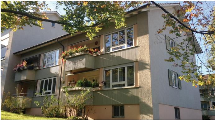
Der «Altbau standard» gemäss HSLU-Studie: Der Altbau stammt aus dem Jahr 1954 und wurde mit Backsteinfassade und Stahlbetondecken errichtet. Foto: CCTP, HSLU
