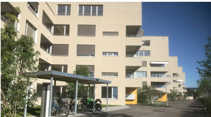
Der «Neubau massiv» gemäss HSLU-Studie: 2017 erbaute Minerergie-Gebäude. Die Massivbauten haben einen automatisierten Sonnenschutz und eine mechanische Lüftungsanlage. Foto: B. Vogel
