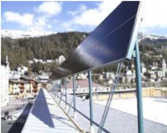
**Figure 12:** Installation à St-Moritz équipée de modules CIS (Source: TISO)
