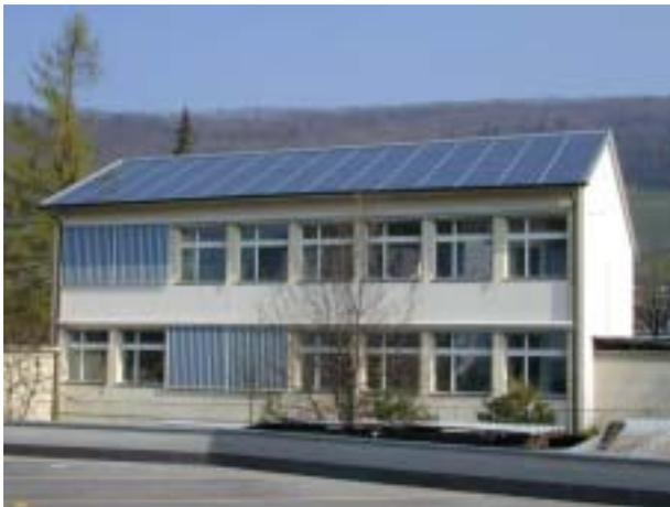
**Figure 10:** Intégration en toiture avec SOLRIF à Wettingen (Source: H.-D. Koepfel)
