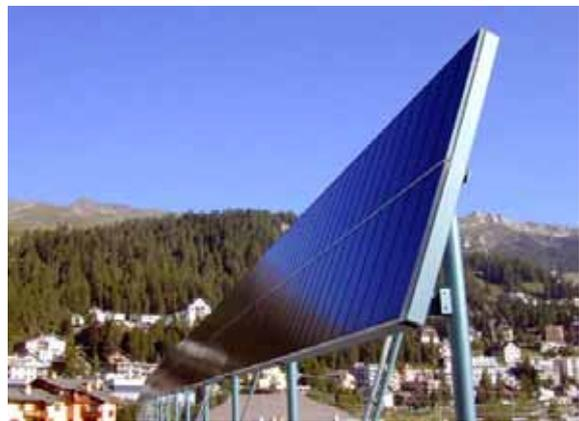
**Figur 35:** 16.8 kWp Anlage mit CIS Zellen St. Moritz
