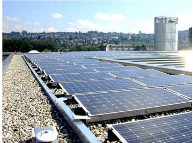
**Figur 29:** 47 kWp Flachdachanlage IBM Zürich
