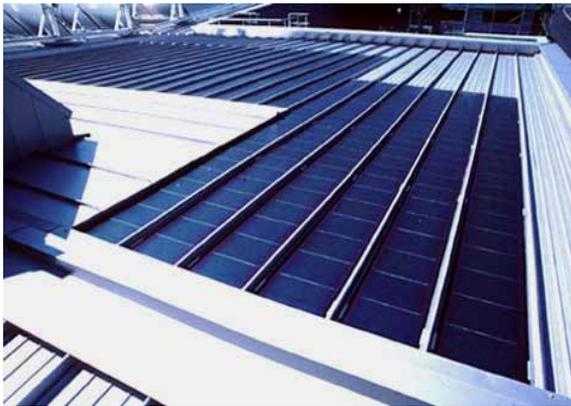
**Figur 32:** 3 kWp PV Eurodach mit amorphen Zellen
