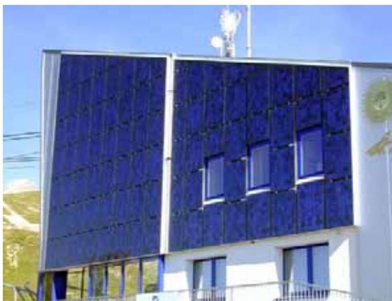
**Figur 26:** 9.7 kWp Fassade 'Piz Nair Talstation'
