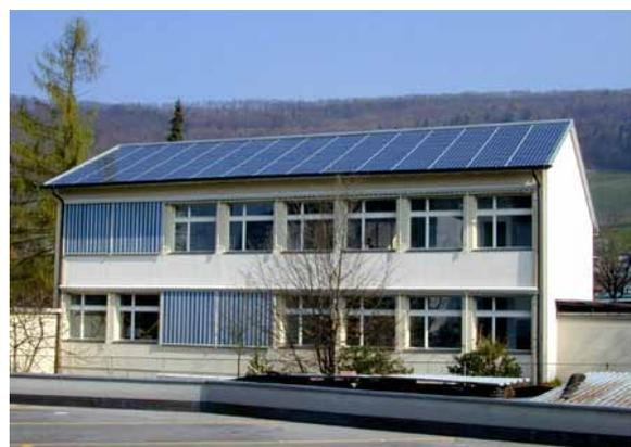
**Figur 31:** 12.75 kWp Dachintegration Wettingen
