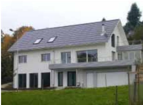
Bild 4: Dachintegration mit SOLRIF
