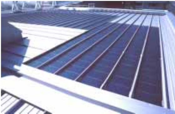
Bild 6: PV Metallfalzdach thermisch isoliert
