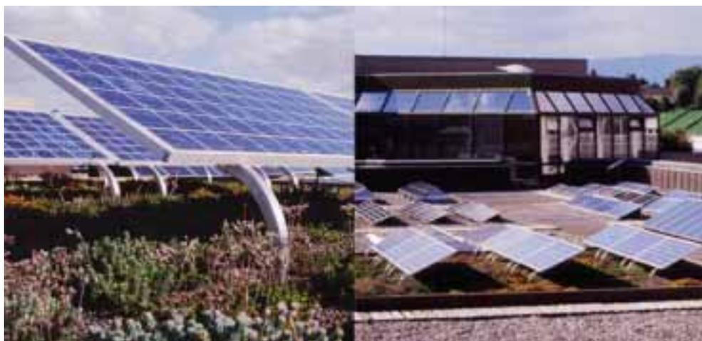
Bild 2: Gründach Photovoltaik Anlage mit Solgreen an der EPF Lausanne
