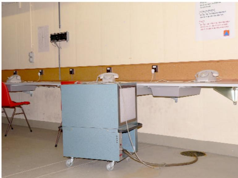
Bei Versuchsbeginn stand der Entfeuchter im Kommunikationsraum in einer Wasserlache, weil der Bodenablauf verstopft war. Die Rostflecken auf dem Boden neben dem Ablauf sind noch Überbleibsel davon. Dieser Entfeuchter konnte also seine Arbeit gar nicht mehr erfüllen und konsumierte völlig nutzlos täglich 18 kWh elektrische Energie.
