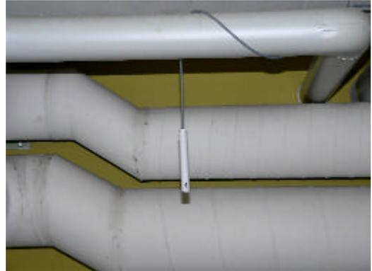
Der Aussensensor ist in dieser Anlage weit vom Regelrechner entfernt. Weil mehrere Panzertüren überwunden werden mussten, verwendeten wir hier das bewährte und robuste F2E-Telefonkabel der Armee zur Signalübermittlung. Das Bild zeigt die Übergabestelle im Vorraum vor dem Nebeneingang.
