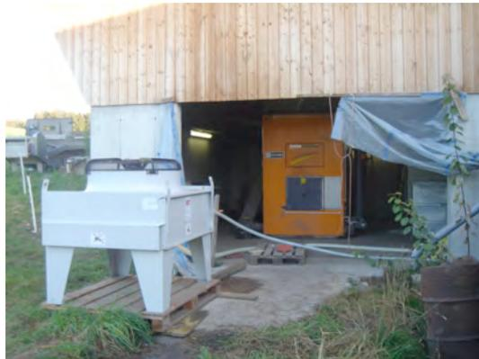
*Abbildung 5 Behelfsmässig installierter Rückkühler (im Vordergrund), um die bei den Verbrennungsversuchen produzierte Wärme abzuführen. Im Hintergrund die Rostfeuerung, auf welcher die Versuche durchgeführt wurden*
