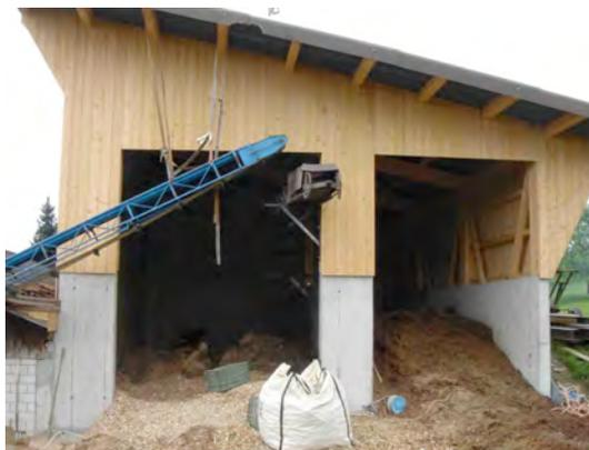
*Abbildung 1: Brennstofflager der Anlage Villiger. Links das Silo für den Hauptbrennstoff «. Rechts das Silo für den Zusatzbrennstoff, welcher dem Hauptbrennstoff zugemischt werden kann. Auf dem Bild wird als Zusatzbrennstoff Pferdemist verwendet.*
