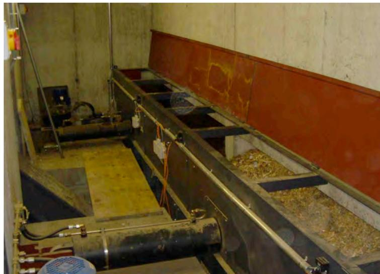
Abbildung 3: Brennstoffaustragung aus den beiden Silos. Im Vordergrund ist der Hydraulikzylinder des Schubbodens des Hauptsilos zu sehen sowie die mit Hackschnitzeln gefüllte Queraustragung. Im Hintergrund dasselbe für den Zusatzbrennstoff (in dieser Aufnahme Pferdemist). In der Mitte rechts befindet sich der Mischschacht. In der Mitte links ist ein kurzes Stück des Steilförderkanals zu sehen.
