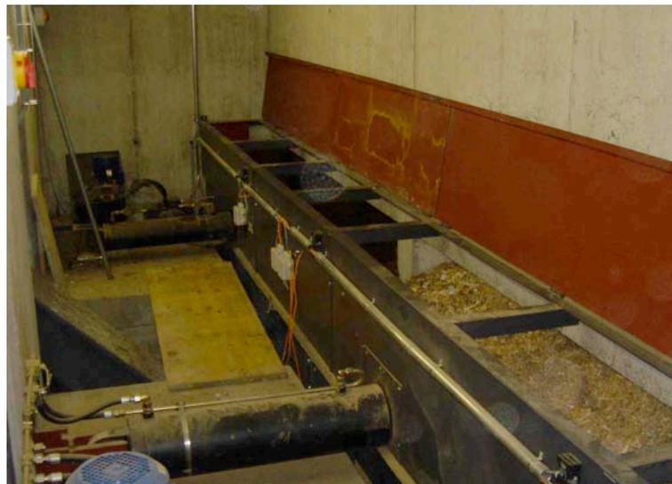
*Abbildung 4:* Brennstoffaustragung aus den beiden Silos. Im Vordergrund ist der Hydraulikzylinder des Schubbodens des Hauptsilos zu sehen sowie die mit Hackschnitzeln gefüllte Queraustragung. Im Hintergrund dasselbe für den Zusatzbrennstoff (in dieser Aufnahme Pferdemist). In der Mitte rechts befindet sich der Mischschacht. In der Mitte links ist ein kurzes Stück des Steilförderkanals zu sehen.
