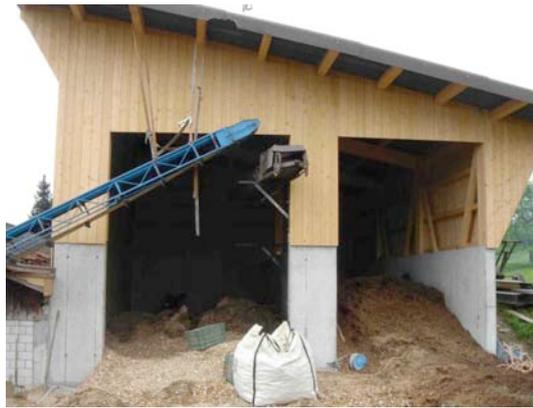
*Abbildung 2:* Brennstofflager der Anlage Villiger. Links das Silo für den Hauptbrennstoff «Hack-schnitzel». Rechts das Silo für den Zusatzbrennstoff, welcher dem Hauptbrennstoff zugemischt werden kann. Auf dem Bild wird als Zusatzbrennstoff Pferdemist verwendet.
