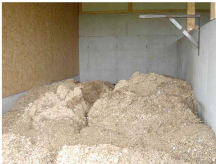
*Abbildung 6:* Hauptsilo mit Hauptbrennstoff: Hackschnitzel von Baurestholz und Restholz aus der Holzverarbeitung (Spanplattenabschnitte)
