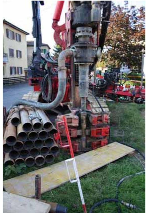
Bohrtisch und Bohrgestänge beim Bohren einer Erdwärmesonde
