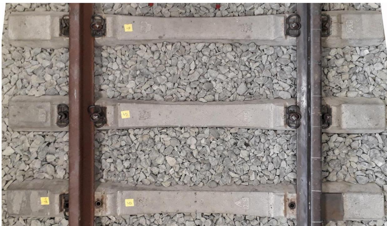
Abbildung 5-1: Betonschwellen B70 im S&V Testgleis
