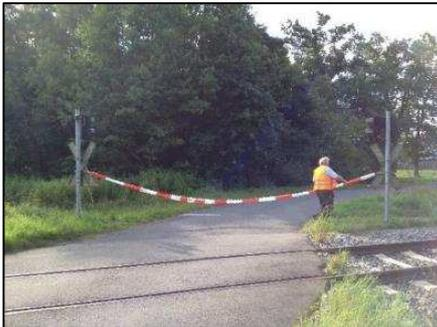
Abbildung 44: Sichern eines Bahnüberganges
